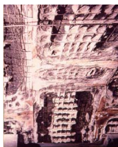
Φωτογραφία 1: Εικόνες καταστροφής της επένδυσης της σήραγγας (Krause 2006) Photograph 1: Pictures of the destruction of the tunnel lining (Krause 2006)
