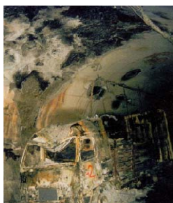
Φωτογραφία 1: Εικόνες καταστροφής της επένδυσης της σήραγγας (Krause 2006) Photograph 1: Pictures of the destruction of the tunnel lining (Krause 2006)
