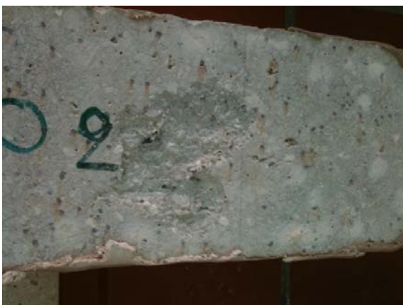
Φωτογραφία 2: Εικόνα αποφλοίωσης δοκίμιου σκυροδέματος Photograph 2: Picture of spalling of a concrete sample
